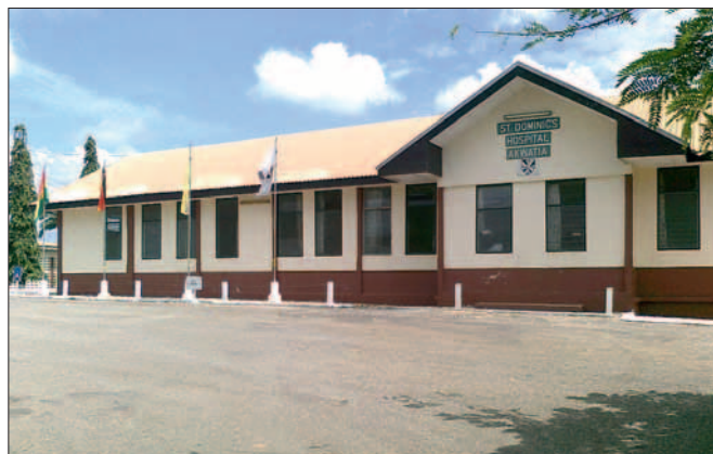
Das St. Dominic Hospital ist das größte von mehreren Missionskrankenhäusern in Ghana. Foto: privat
